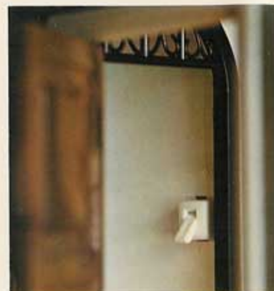
Här sitter strömbrytaren som du kan tända och släcka alla lampor med på en gång.
